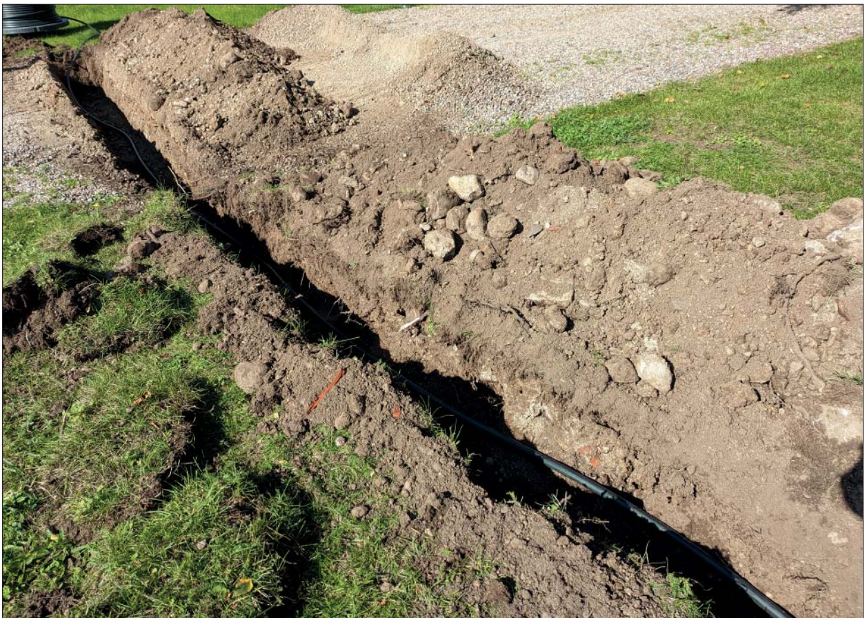
Figur 10. Stenar, tegel och kalkbruk i schaktets västra del sedda från sydöst. Foto Ann-Charlott Feldt, ÖM.
