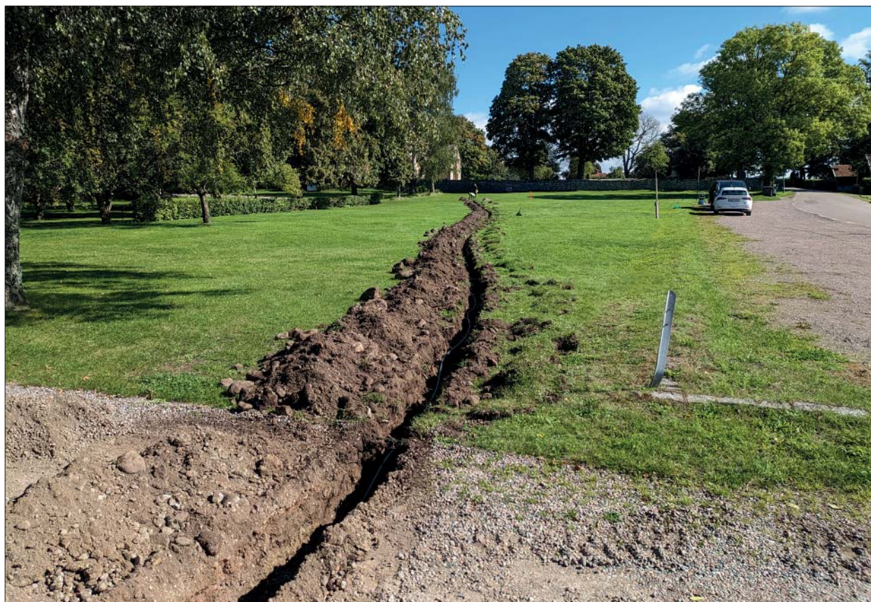
Figur 8. Schaktet sett från väster. Bakom träden i fonden ans Örberga kyrka. Foto Ann-Charlott Feldt, ÖM.
