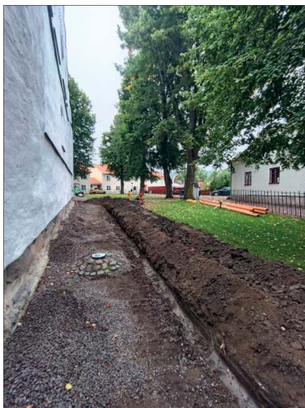
Figur 8 t v. Schaktet togs upp utmed kyrkans östra gavel. Foto mot norr, Helén Romedahl, ÖM.
