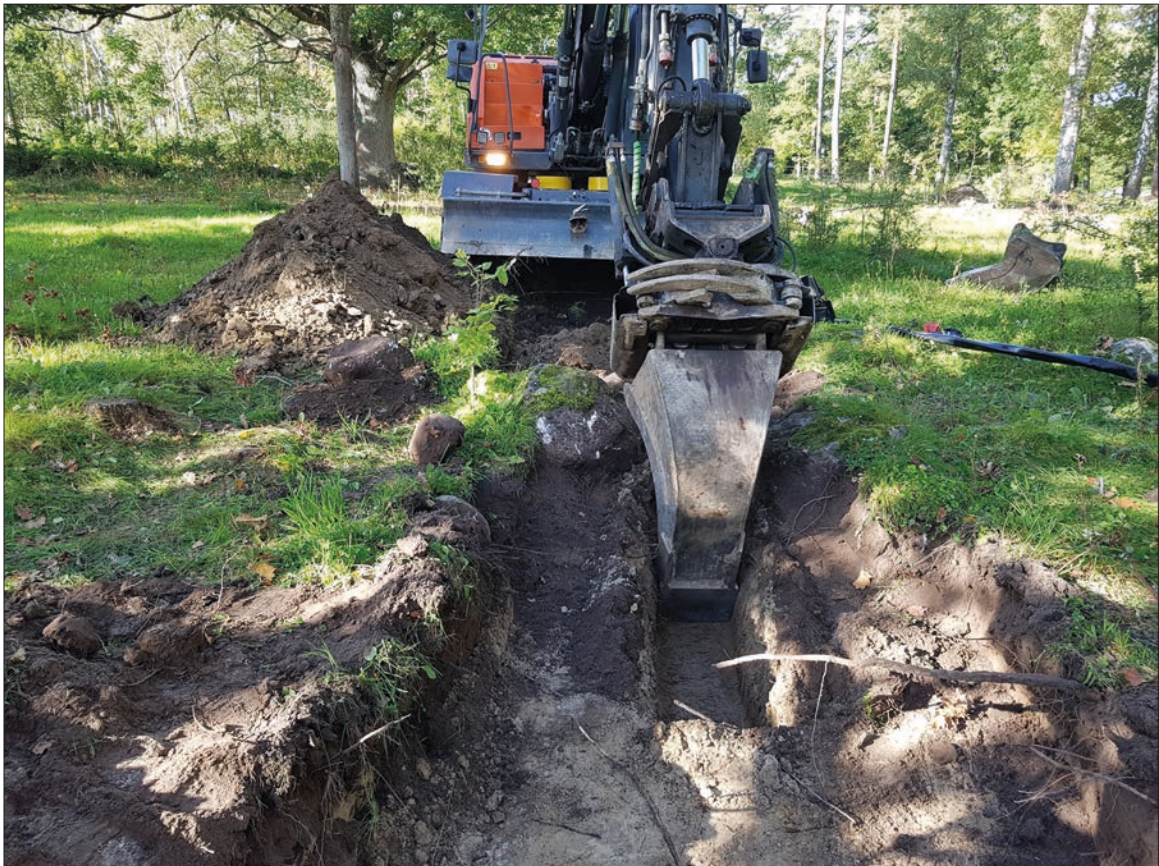
Figur 7. Grävning av djupschakt för kabeln genom A309, mot VNV. Foto Anders Olofsson, ÖM.
