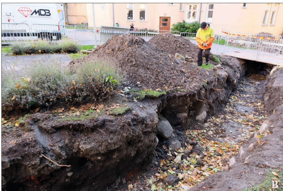
Figur 13. Översiktsfoton över Schakt 2 före schaktväggen rensades upp. A: Den södra delen av schaktet var vattenfylldt p g a läckande dagvatten. I den östra schaktväggen fanns tunna remsor av bevarade kulturlager (mörka partier). Schaktet tangerade befintliga ledingschakt fyllda med sand vilket ledde till att schaktväggen var instabil. Mot sydost. B: Kvarlämnade jordhögar ytinventerades efter fynd. Mot sydväst. C: Den norra delen av schaktet innehöll välbevarade lämningar. Mot söder. D: Körplåtar täckte över delar av schaktet. Mot nordväst. Foto Emma Karlsson, ÖM.
