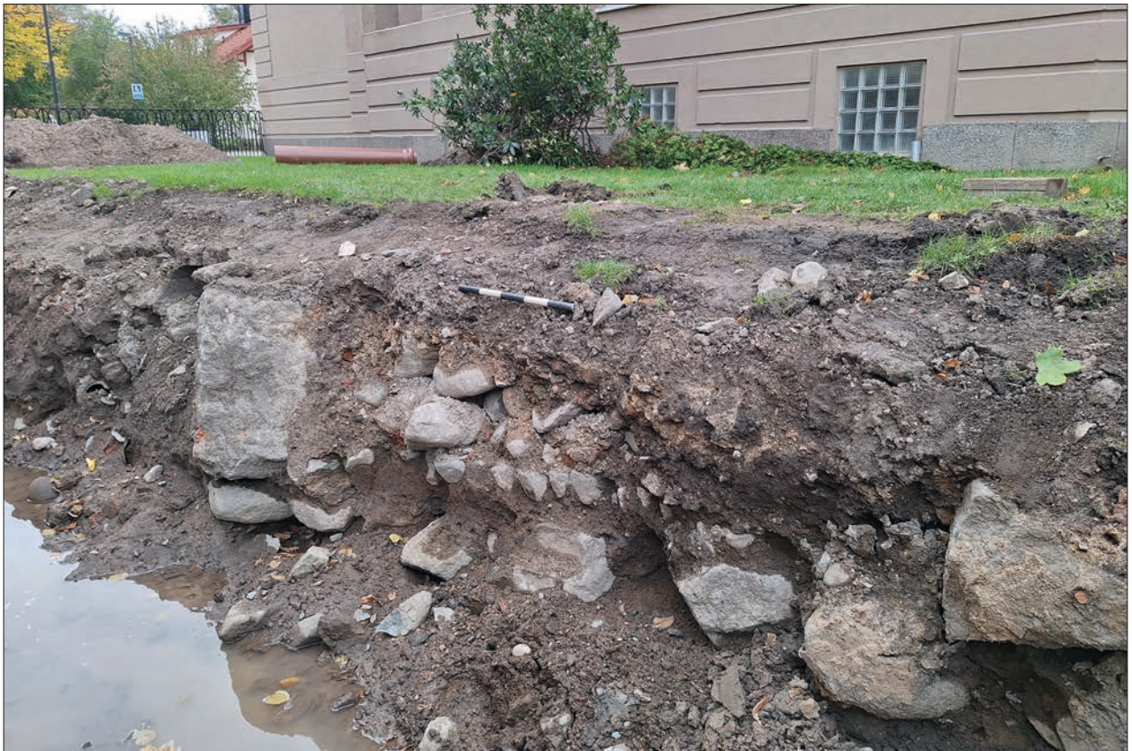
Figur 23. Stenkonstruktion tolkad som en möjlig väg från sekelskiftet 1800. Mot sydväst. Foto Emma Karlsson, ÖM.
