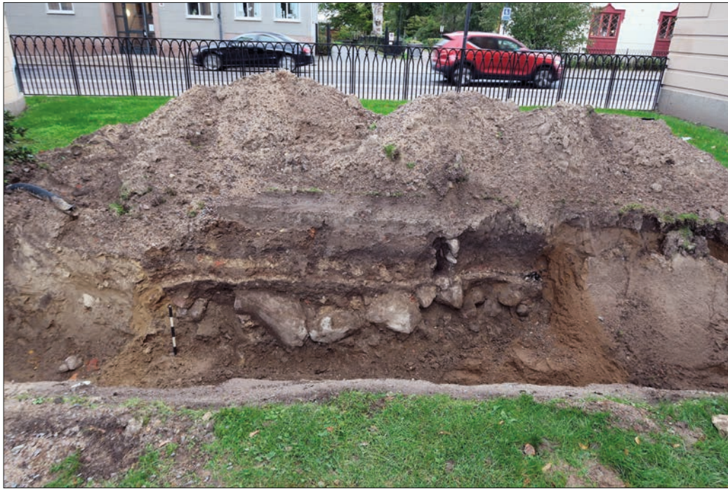
Figur 10. Stenfundamentet och de tunna kalkbrukslagren syns tydligt i rensade schaktväggen. Mot söder. Foto Emma Karlsson, ÖM.
