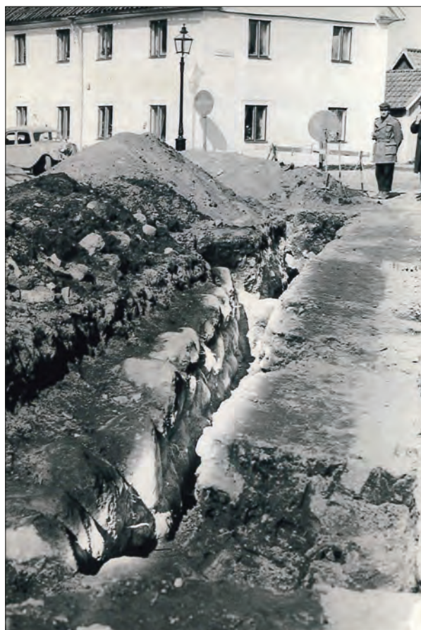
Figur 3. Schaktning i Järntorgsgatan 1960. I schaktet ses den påträffade husgrunden. Bakom avspärrningen ses början på Återvändsgränd. Foto mot norr, L. Niklasson.
