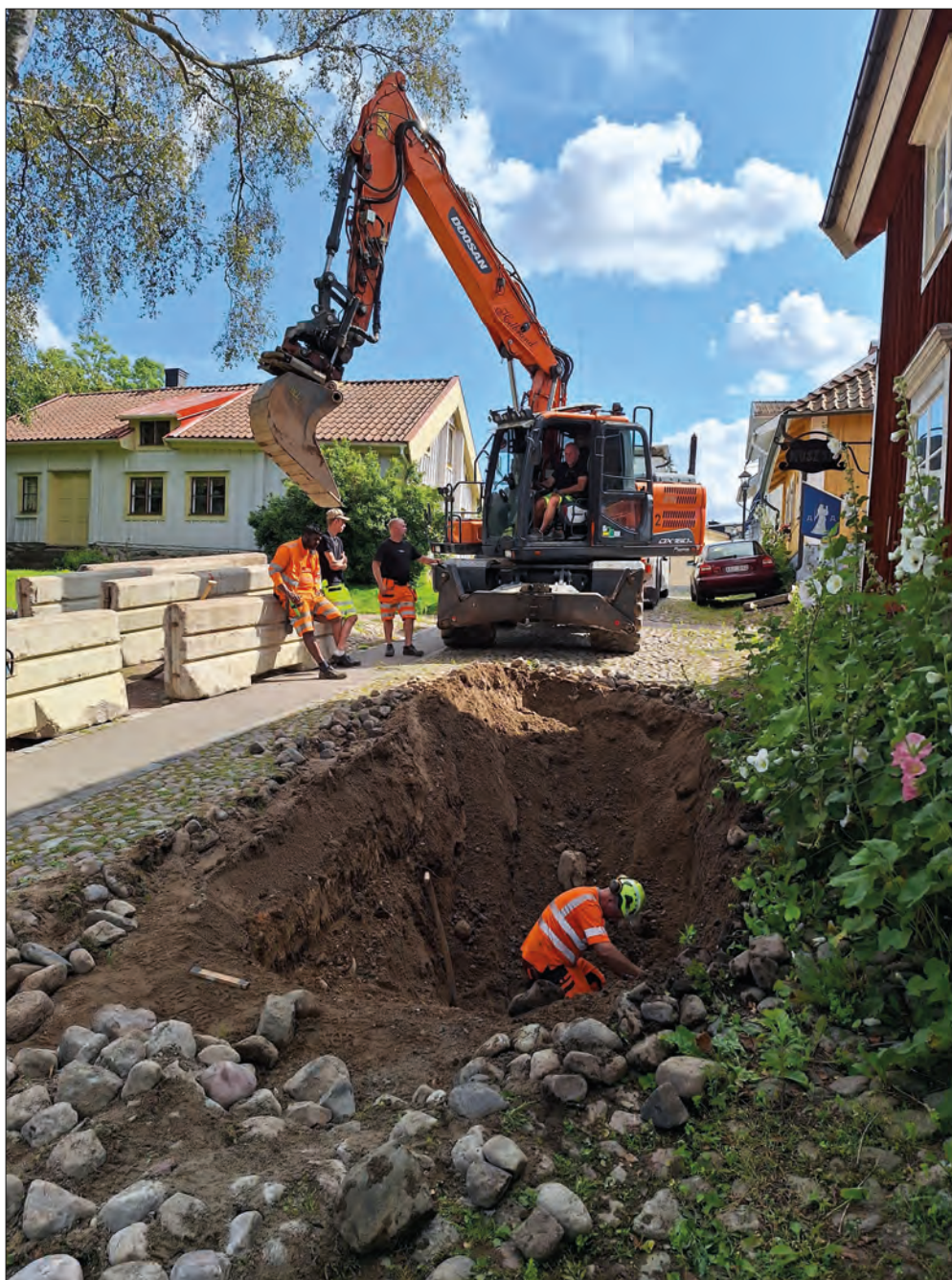
Figur 5. Det öppnade schaktet sett mot söder. Foto Emma Karlsson, ÖM.
