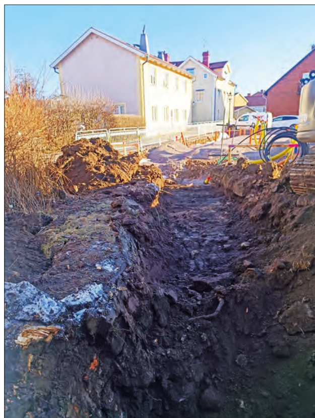
Figur 15. Schakt 3042. Foto mot öster, Helén Romedahl, ÖM.
