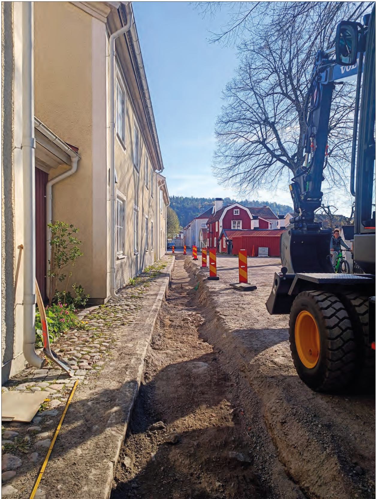
Figur 3. Schaktet i Drothemsgatan. Foto mot öster, Helén Romedahl, ÖM.
