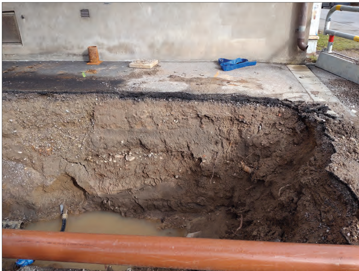
Figur 9. Kulturlager i den norra schaktväggen i schakt 4. Foto: Ann-Charlott Feldt, ÖM.
