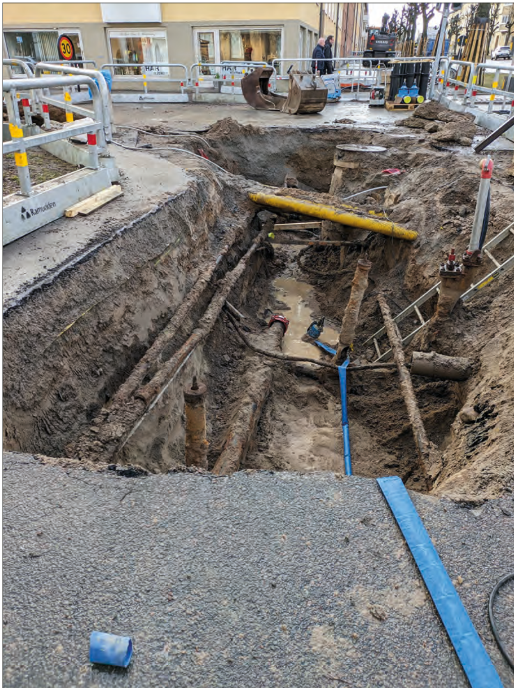
Figur 8. Schakt 14 på Vasavägens södra sida vid korsningen med Vallgatan, sett från öster. Den stora mängden olika ledningar i schaktet visar på den omfattande urschaktningen längs sträckan. Foto: Ann-Charlott Feldt, ÖM.
