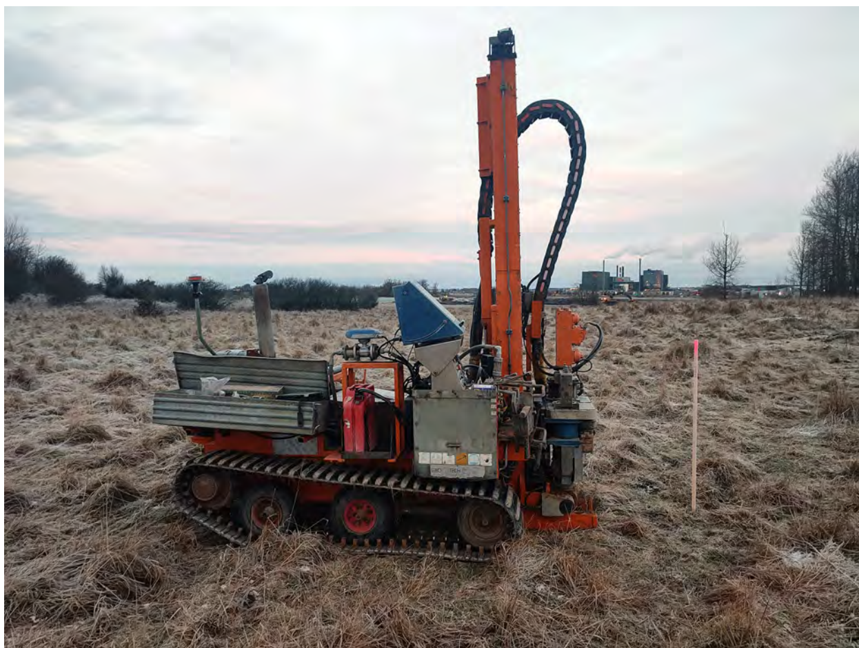
Figur 5. Borrhningarna utfördes med en mindre bandburen borrsvagn. Arkeolog medverkade vid behov i samband med förflyttning av borrsvagnen för att undvika skador på fornlämningar. Från SV. Foto Per Nilsson.
