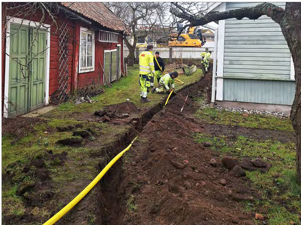
Figur 4. Den nya ledningen läggs på plats. Foto mot väster, Helén Romedahl, ÖM.
