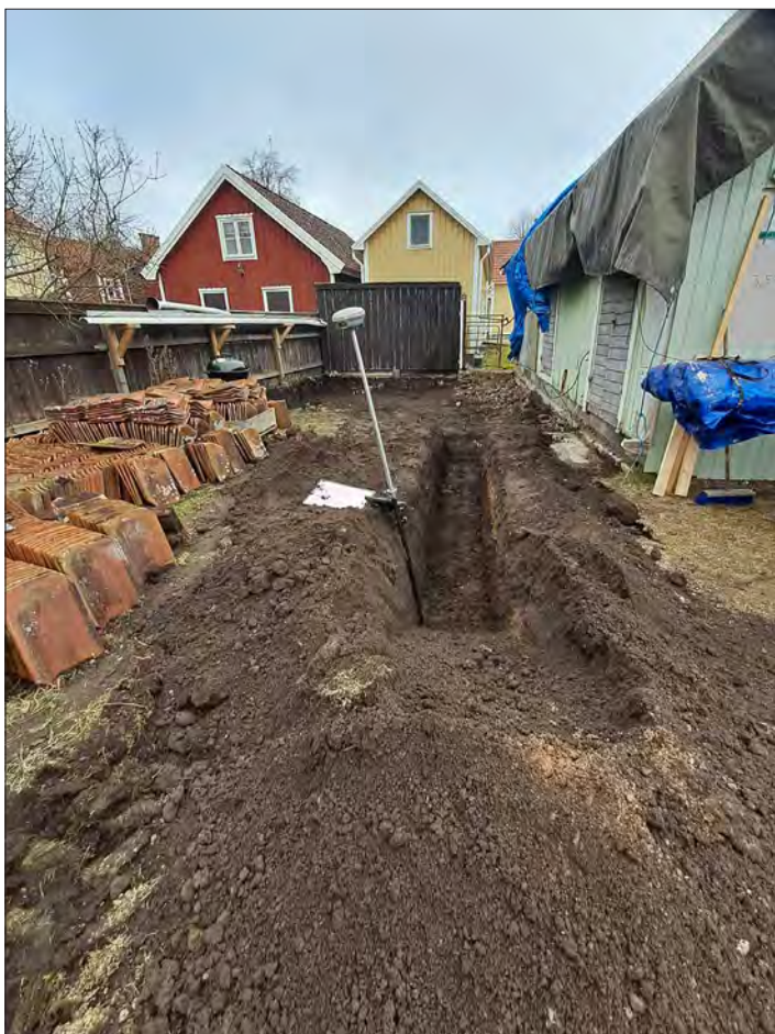
Figur 8. Andra schaktetappen togs upp i gräsmattan. Foto mot väster, Helén Romedahl, ÖM.
