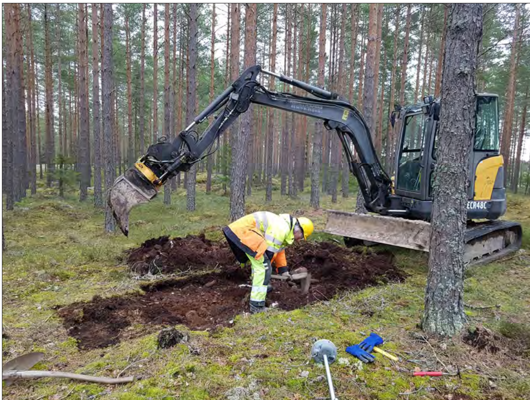
Objekt III, schaktning av S233, från V. Foto Anders Olofsson, ÖM.
