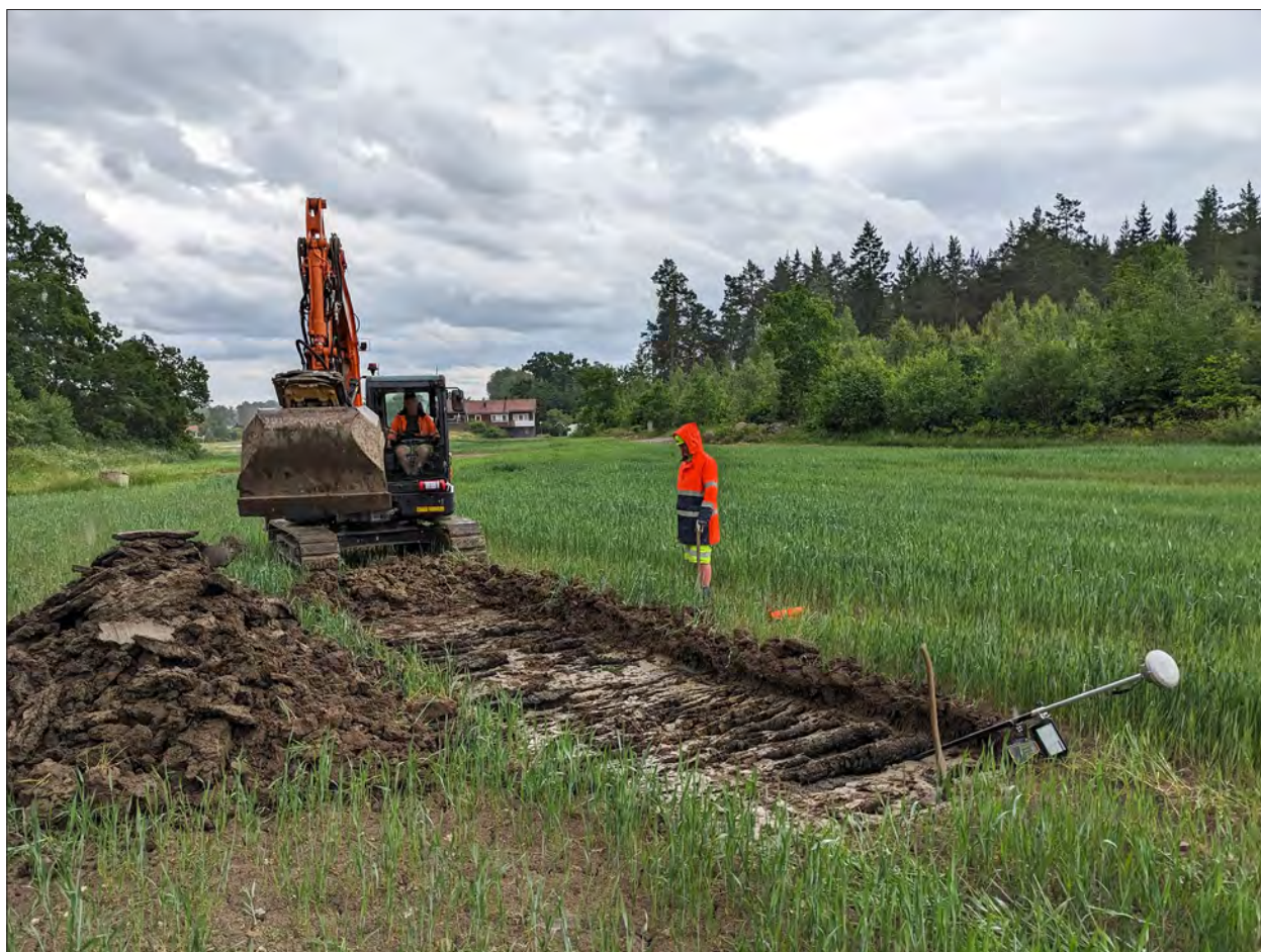
Figur 4. Arbetsbild, schaktning vid Objekt I. Foto från NNV, Roger Lundgren, ÖM.
