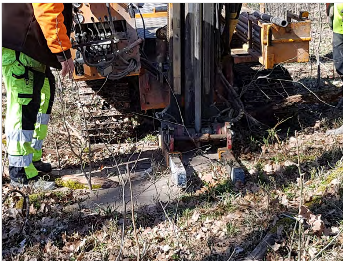
Figur 5. Borrning av borrhål 3C4139 vid Bådstorp. Foto Anders Olofsson, ÖM.
