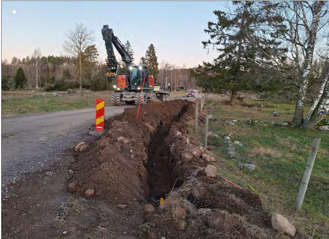
Figur 10. Översiktbild över Schakt 1, mot söder norr. Foto Emma Karlsson, ÖM.
