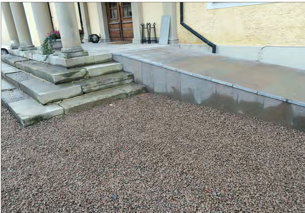
Figur 12. Den färdiga rampen innan räcket monterats, sedd från nordväst. Foto Johan Bergström, ÖM.
