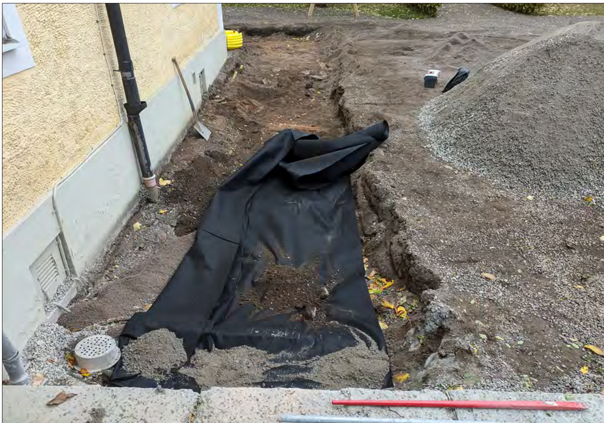
Figur 11. De framkomna lämningarna täcktes av en kraftig geotextil innan bärlager lades på och rampen byggdes. Foto från trappan i öster. Foto Ann-Charlott Feldt, ÖM.
