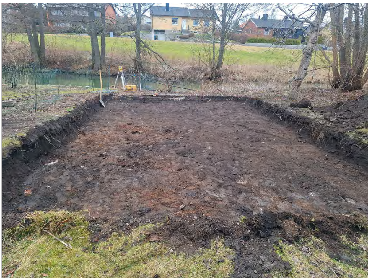
Figur 5. Färdigschaktat. Möjligen anas toppen på ett kulturlager i schaktets södra hörn (till vänster i bild). Lagret kvarligger. Foto mot väster; Helén Romedahl, ÖM.
