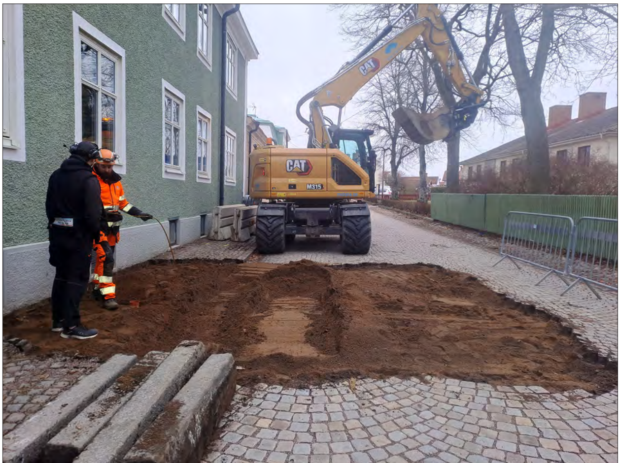
Figur 4. Schaktet. Foto mot sydöst, Helén Romedahl, ÖM.
