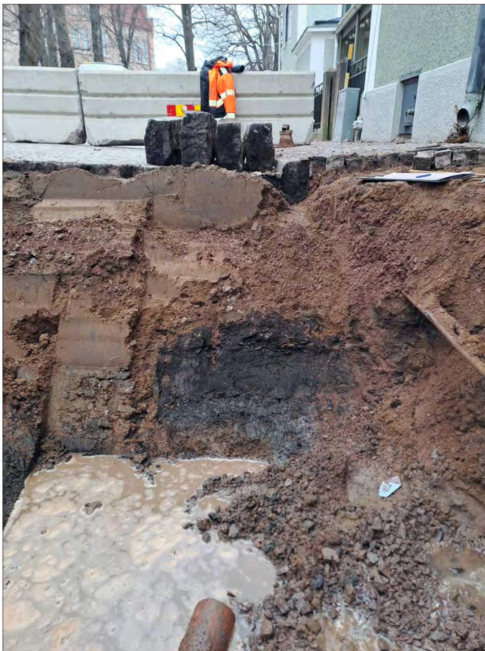
Figur 7. Bevarade lager i norra schaktsektionen, se även ritning (bilaga 1). Foto mot norr, Helén Romedahl, ÖM.
