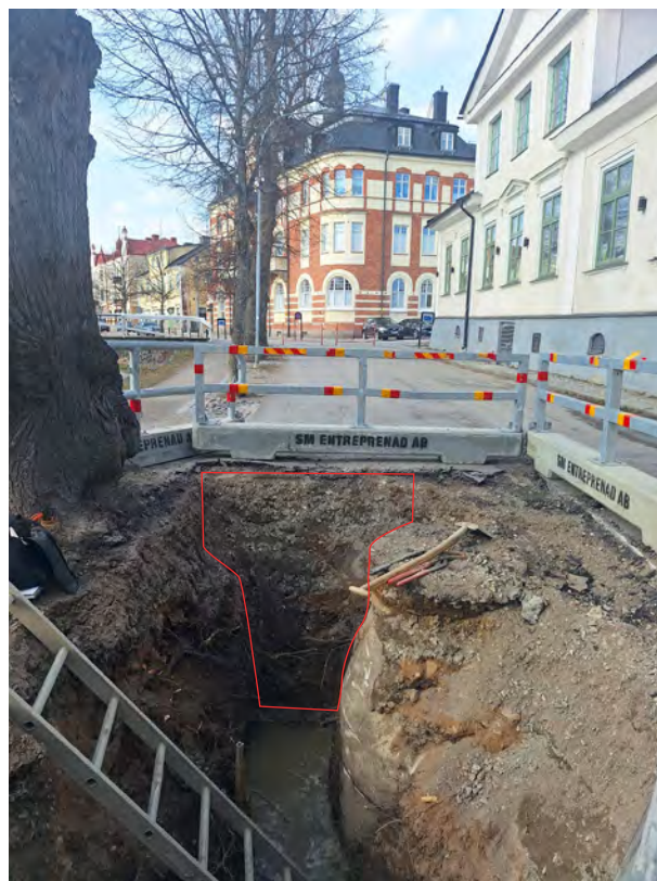
Figur 6. Schakt 516 efter grävning. I västra schaktväggen fanns en bevarad sekvens med lager (röd markering). Foto mot väster, Helén Romedahl, ÖM.
