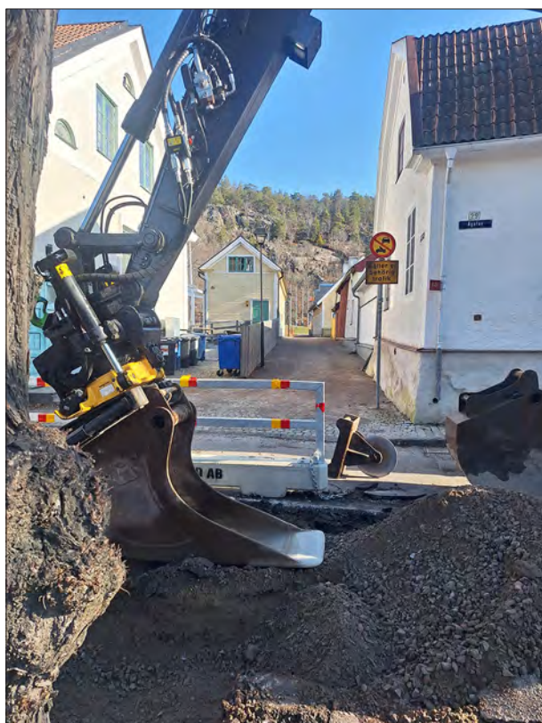
Figur 5. Schakt 516 mitt för Slussgränd. Foto mot nordöst, Helén Romedahl, ÖM.
