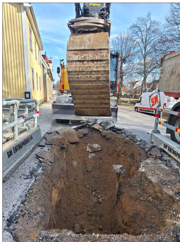
Figur 7. Schakt 524 innehöll enbart moderna fyllnadsmassor med sand och grus. Foto mot öster, Helén Romedahl, ÖM.
